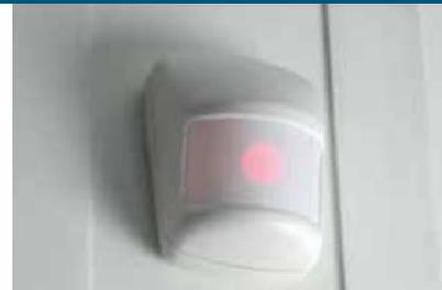
Die installierten Melder und Sensoren senden bei Auslösung ein Funksignal an die Alarmzentrale.
